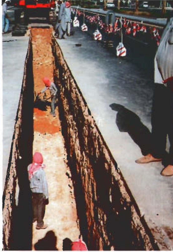
نظام صرف المياه الأرضية بالمصيف
