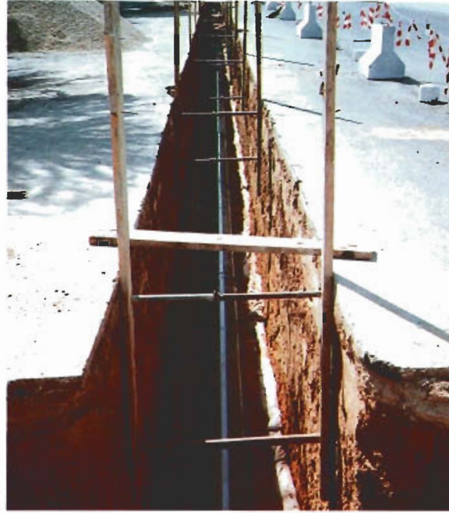
نظام صرف المياه الأرضية بأم الحمام
