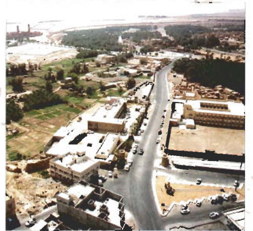
منطقة سمحان ويظهر مبنى البلدية في وسط الصورة
