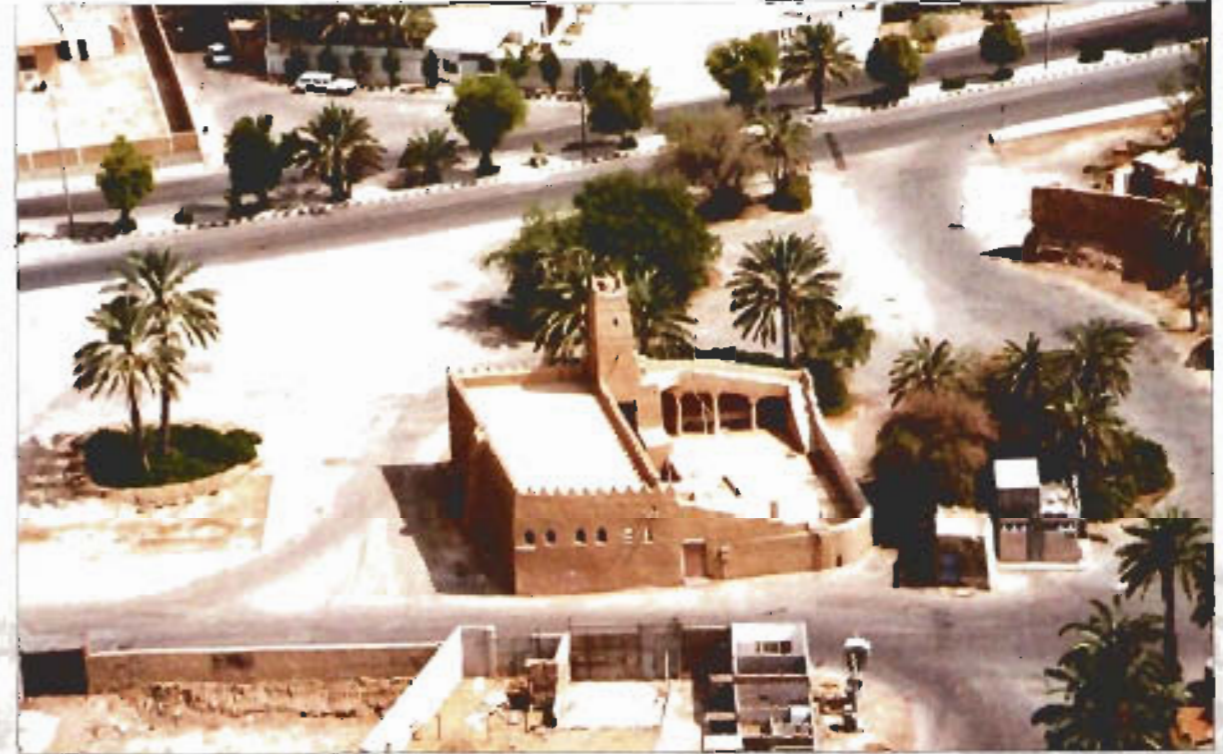
مسجد الظويهرة بعد هدم البيوت الطينية المحيطة به
