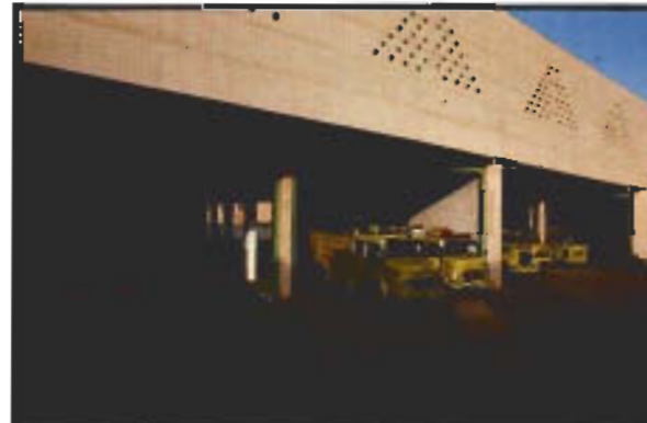
مركز اطفاء بمبنى حكومي
