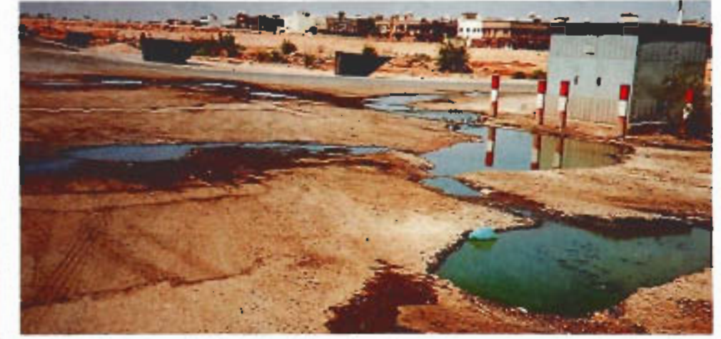
تهشم طبقات الرصف
