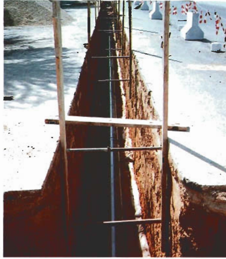
نظام صرف المياه الأرضية بأم الحمام
