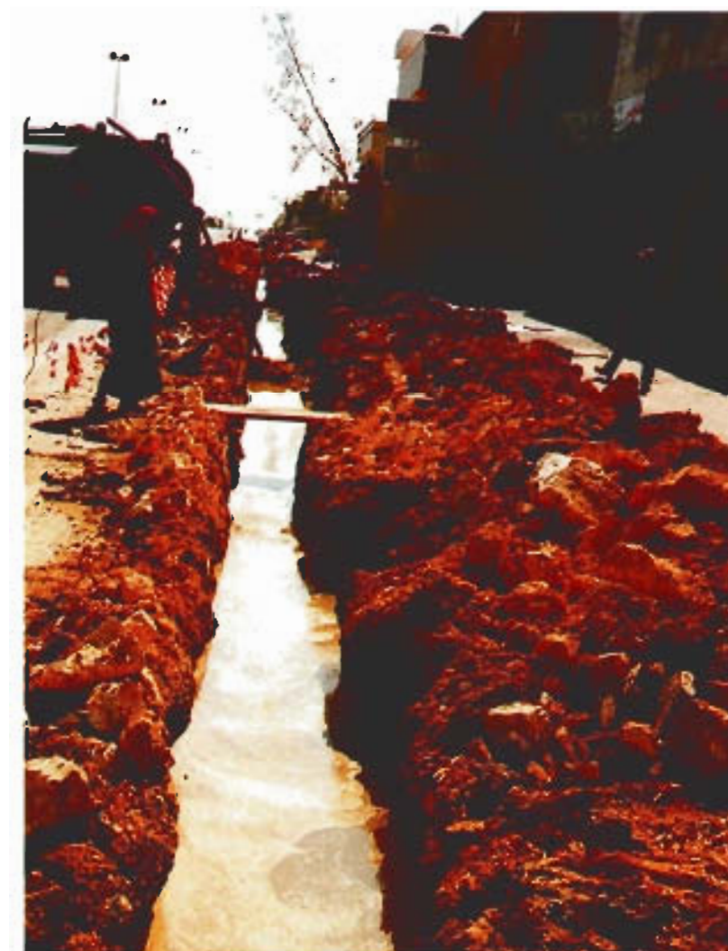
وجود المياه الأرضية بالقرب من سطح الأرض أثناء تنفيذ مشاريع المرافق العامة
