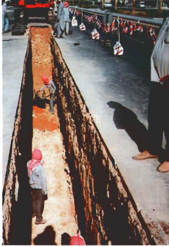
نظام صرف المياه الأرضية بالمصيف
